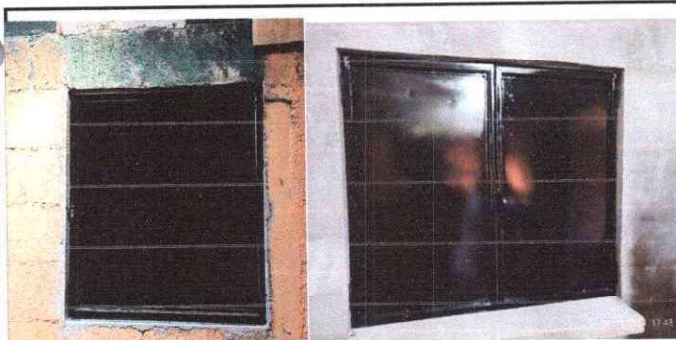
Foto 5: Instalación de dos ventanas de cocina de metal.
