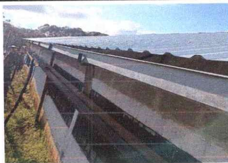
Foto 4: Instalación de canales en aulas y corredor del Centro Educativo.
