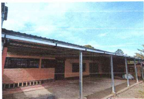
Foto1: Instalación de entechado completo en aulas, corredor, cocina y pasillo
