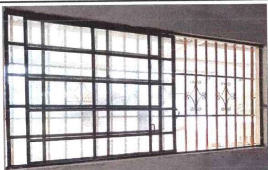
Foto 3: Suministro y reparación de dos ventanas corredizas en dos aulas
